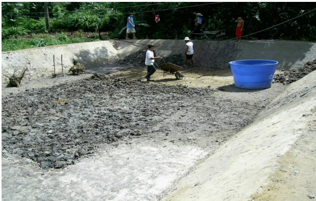
Figura 4 - Viveiro sendo recapeado com argila para impermeabilização dos viveiros.
