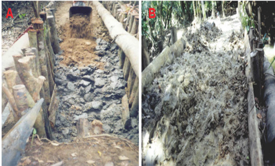
Figura 9 - Barragem em processo de construção mostrando a estrutura de madeira e preenchimento com o material da própria várzea.
