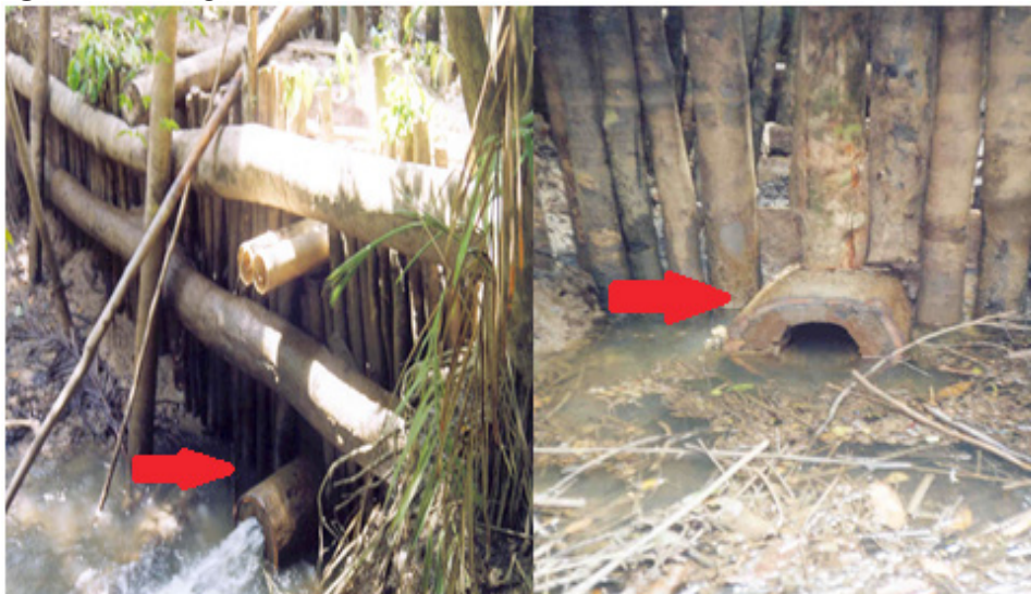
Figura 10 - Barragem artesanal mostrando dreno de tronco de árvore.
