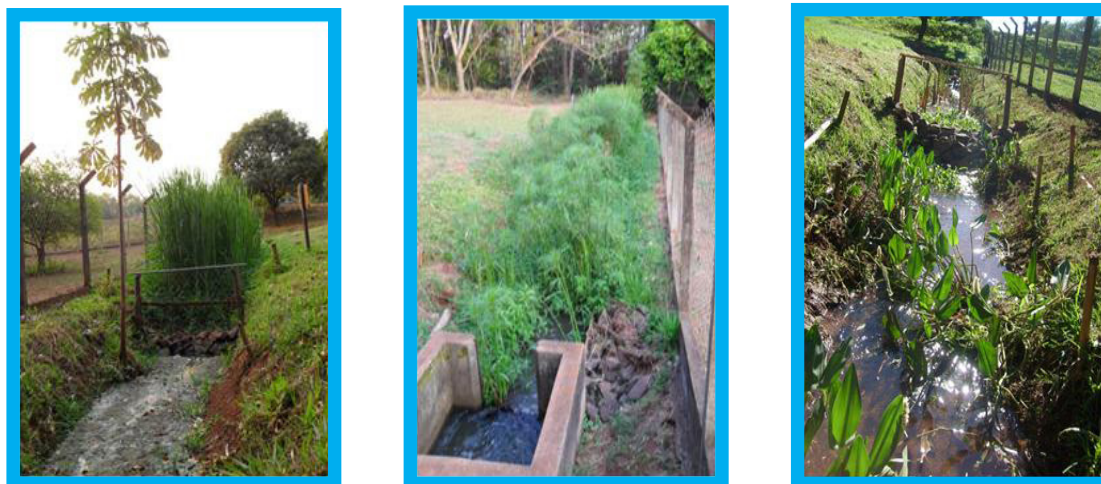
Figura 2 - Vista parcial de um wetland construído no efluente do sistema de aquicultura do CAUNESP, Jaboticabal, SP.
