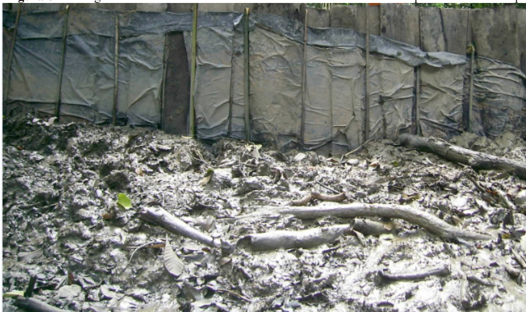
Figura 8 - Barragem construída com casca ou lascas de madeira de lei e encapamento com lona plástica.
