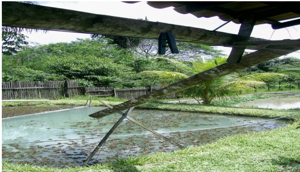
Figura 1 - Sistema de captação de água da chuva utilizando calha de casca de pupunheira, Bactris gasipaes .
